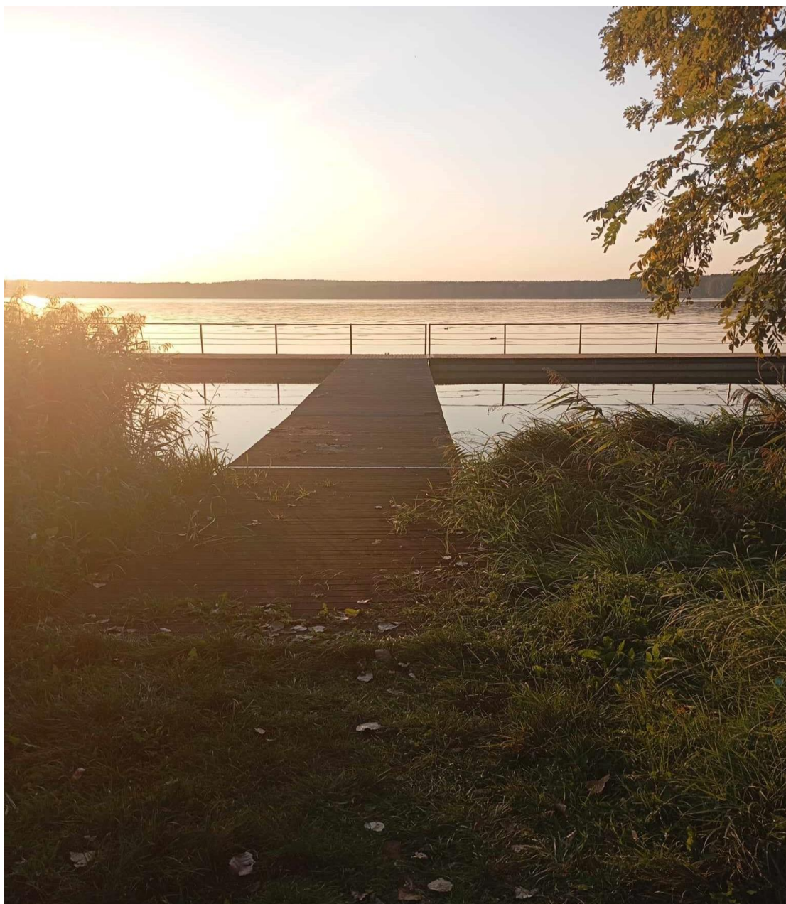
Zarzęcin – Molo wykonane z konstrukcji drewnianej z metalowymi barierkami zabezpieczającymi.
